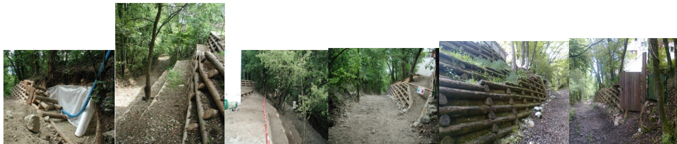
Après ce programme de transformation et ces 4 niveaux de terrassement réalisée en bûches de Mélèzes - et 3 ans après ! Beaucoup plus agréable et « vert » qu'un mur en béton ou des gabions en pierres...
